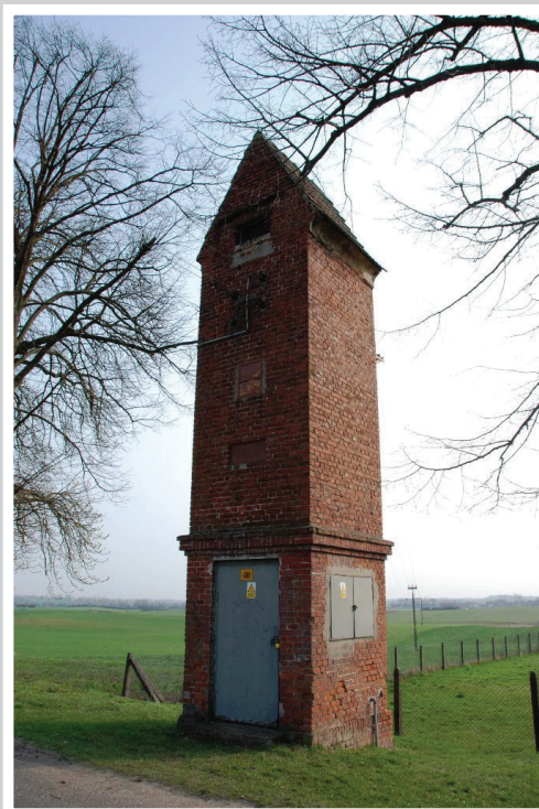
330. Trafostacja w Derczewku z I ćwierci xx w. z cegły ceramicznej. Funkcjonuje jako element układu energetycznego (KEZ-A 756)
