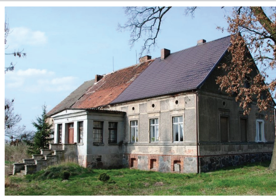
332. Budynek mieszkalny w Głębokiem, wybudowany w 4 ćw. XIX w. Obiekt z cegły (otynkowany), posadowiony na wysokim, granitowym cokole, parterowy, z poddaszem mieszkalnym. Nakryty wysokim dachem dwuspadowym. Wejście główne poprzedzone murem gankiem. Zachowane schody i balustrada. Budynek zachował historyczną formę architektoniczną. (KEZ-A 760)
