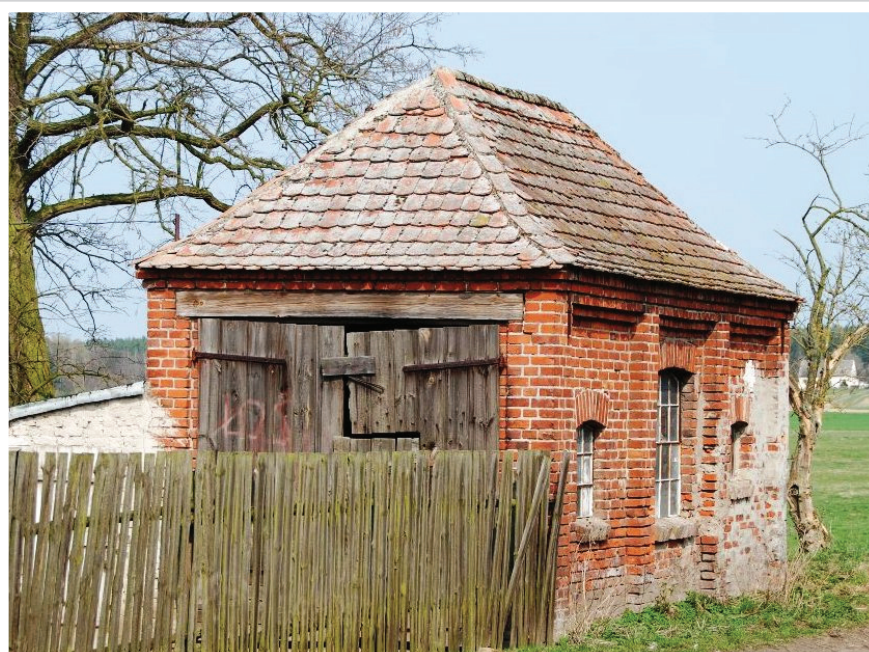
b) niewielka kuźnia (lub warsztat), ceglana, nie-tynkowana. Obiekt wedle fachowców od zabytków Pomorza Zachodniego o wysokich walorach kulturowych (2009) Stanowi cenny przykład historycznej infrastruktury technicznej (KEZ-A 843).
