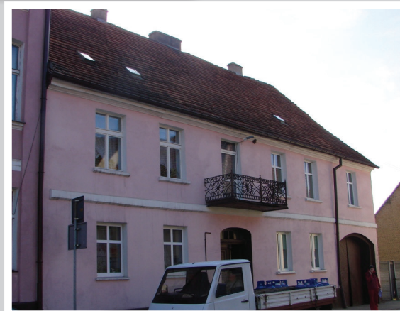
222 a, b Plac Wolności 10, budynek z pocz. XIX w. w pierzei wsch. Oś wejściowa zaakcentowana balkonem I piętra z historyczną metalową balustradą (KEZ -A 732)
