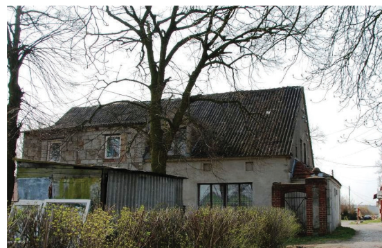
358 a-c. Zagroda czterobudynkowa w Osetnej – dawny folwark (duże gospodarstwo), w tym: ceglany budynek stodołno-inwentarski – zlokalizowany w zachodniej części siedliska, szczytem do drogi.
