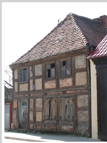
300. Niepodległości 12 z ok. 1800, wąskofrontowy z przełotowym korytarzem i pozostałością czarnej kuchni, w 2009(KZPP s. 90 i fig.223)
