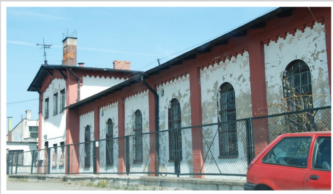
302. Na obszernej działce na rogu z ul. Jedności Narodowej budynek z 1903 (data na chorągiewce wiatrowskazu) dwubryłowy, dawna elektrownia, z cegły ceramicznej (KEZ_A-599)
