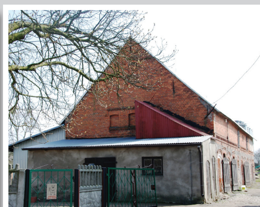
365a. Budynek inwentarski, szczytem do drogi, nietynkowany, parterowy, z obszernym poddaszem składowym, nakryty wysokim dachem dwuspadowym. (KEZ-A 824).
