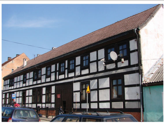
295. Szkolna 17; Budynek ryglowy kiedyś mieszkalny o konstrukcji szkieletowej drewnianej, z pocz. XIX w., nie-podpiwniczony, z dwoma oficynami, z przejazdem bramnym, poddany 1976–1989 renowacji i modernizacji na bibliotekę miejską (m.in. wymiana kamiennego cokołu na ceglany, rozbiórka oficyn zastąpionych nowymi o częściowo zmienionym usytuowaniu). Zachowana drewniana, barokowo-klasycystyczna klatka schodowa. W jednej z piwnic ceglane sklepienie kolebkowe. Wpis. do rej. zab. 1955 (KEZ –A 711).
