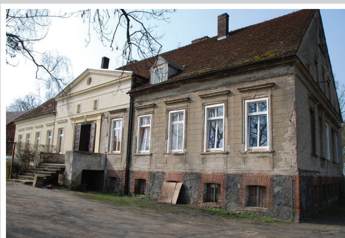
334. Dworek w Jedlicach z IV ćwierci XIX w., z cegły ceramicznej, otynkowany, na wysokim cokole, z mieszkalnym poddaszem nakrytym dachem wysokim. Zachowane oryginalne drzwi główne. Obecnie dom mieszkalny (KEZ-A 761)
