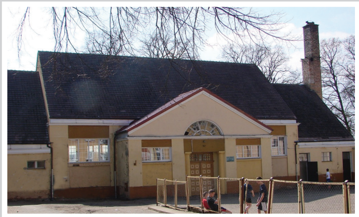
161. Sala sportowa z 1925-35 (Kościuszki 1c). Obiekty wpisano w 1955 r. do rejestru zabytków (KEZ-A 602)
