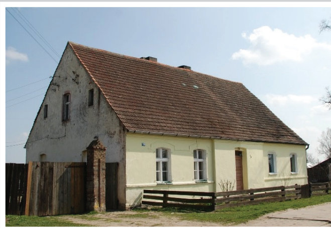
344. Krasne. Budynek mieszkalny z ostatniej ćwierci XIX w. z cegły ceramicznej (otynkowany), z mieszkalnym poddaszem, nakryty wysokim dachem dwuspadowym (KEZ-A 779)
