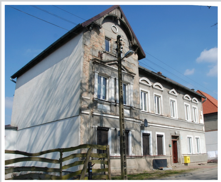
270. Budynek Okrzei 7 z IV ćwierci XIX w., wpisany do rejestru zabytków 1955 (KEZ -A 670)
