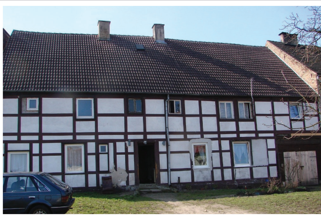
255. Jedności Narodowej 61. Kamienica o konstrukcji szkieletowej z początku XIX w., wpisana w 1955 do rej. zabytków (KEZ-A 587)
