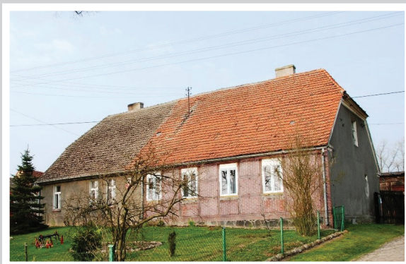
328. Chatupa mieszkalna w Derczewku ze schyłku XIX w. z poddaszem mieszkalnym, nakryta masywnym, dachem. Z cegły ceramicznej z daszkiem namiotowym, z I ćwierci XX w., czynna 2009 (KEZ-A 753-4)
