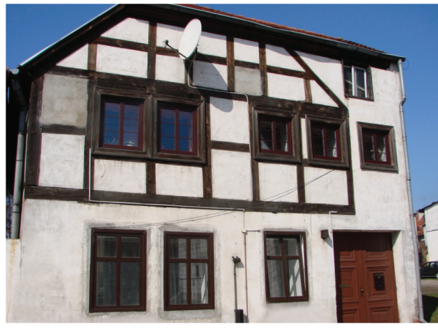
281. Budynek Oświęcimska 6 z I ćwierci XIX w. całkowicie ryglowy, po przebudowie w kierunku płn. w końcu XIX w. w obrębie I kondygnacji mурowany Wpisany do rejestru zabytków 1955 (KEZ –A 678)
