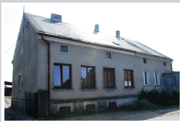
365 Skrzynka. Zagroda czterobudynkowa, po południowej stronie drogi, w tym: 1. budynek mieszkalny z cegły (na kamiennej podmurówce), podpiwniczony, parterowy, zachował pierwotną bryłę i formę dachu z podwyższoną partią poddasza.
