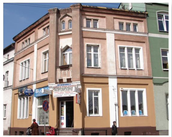
284 Kamienica Mickiewicza 5 z przełomu XIX/XX w., usytuowana narożnikowo, o elewacjach podzielonych lizenami i gzymsami, z apteką kiedyś w przyziemiu. Wpisana do rej. zabytków 1955 (KEZ-A 636)
