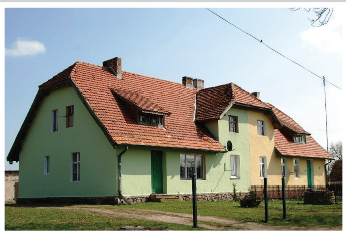
345. Krasne. Budynek mieszkalny (czworak), parterowy, kiedyś dla robotników majątku. z cegły ceramicznej, na kamiennym cokole, otynkowany, podpiwniczony, z mieszkalnym poddaszem. (KEZ-A 780)
