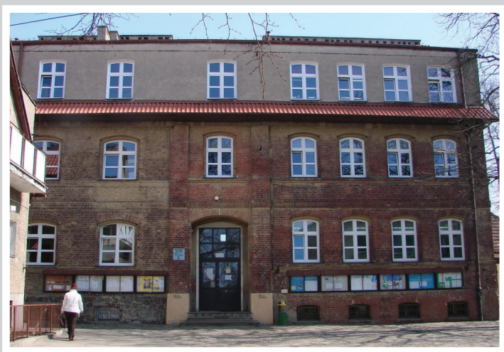
162. Budynek szkoły podstawowej 1875-6 (Kościuszki 1b), rozbudowany w XX w. (KEZ-A 601)
