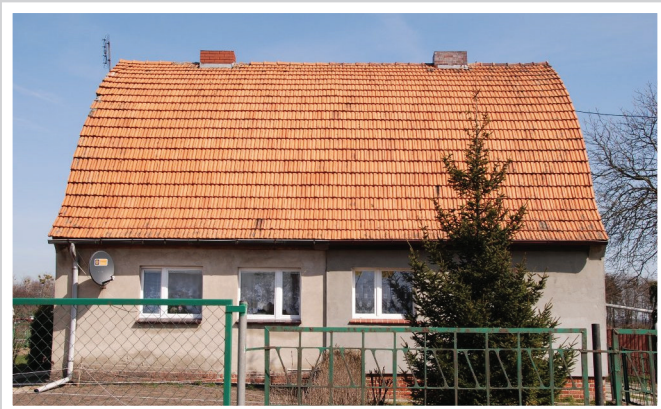
303 a-b. Zespół 11 domów mieszkalnych z lat 30. (Pyrzycka 2-40), dwurodzinnych, parterowych na wydzielonych działkach wzdłuż drogi, z cegły ceramicznej, z wysokimi dachami. W 2009 proponowano objęcie ich opieką konserwatorską (KEZ 684)
