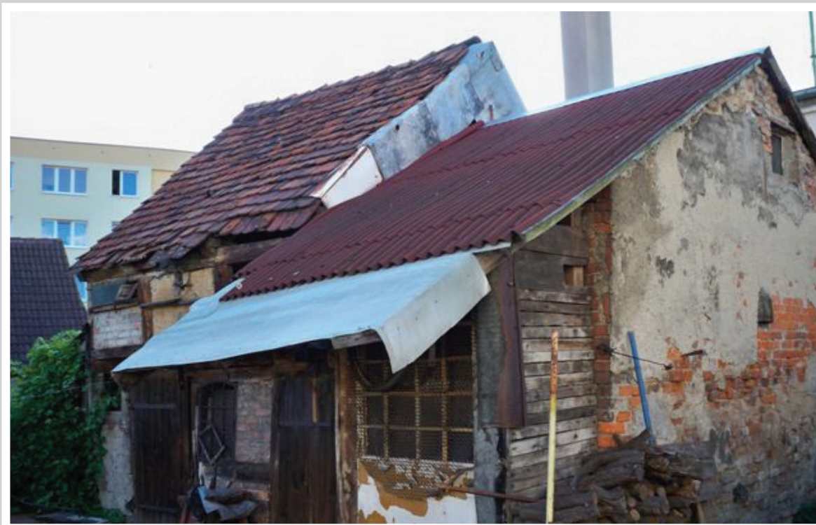
178. Synagoga przed rozbiórką w 2009 r. (ze zbiorów J. Kukiela)
