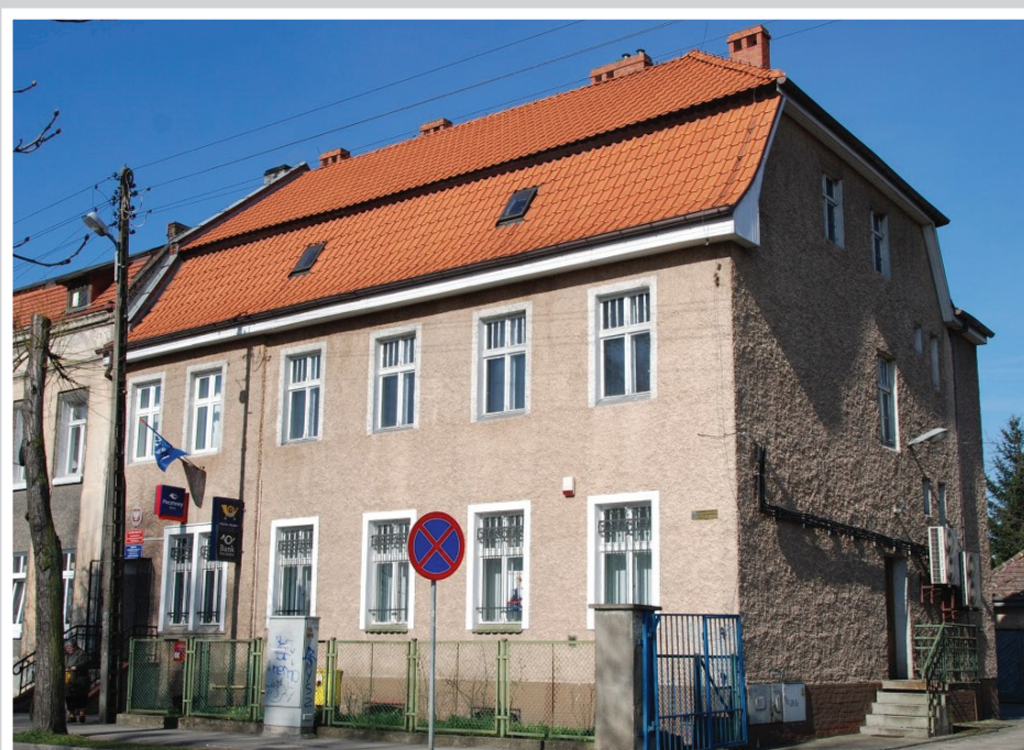
125. Budynek poczty z pocz. XX w. przy ob. ul. Jedności Narodowej 31 (KEZ-A 565)
