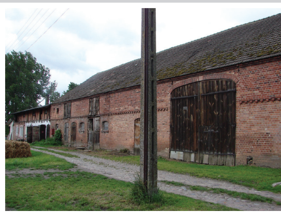
b) ryglowy budynek inwentarski przylegający do bud. stodołno-inwentarskiego, parterowy z poddaszem składowym.;
