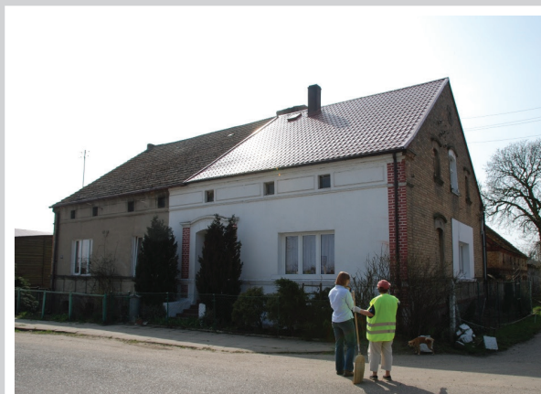
362. Chatupa w obrębie dużej czterobudynkowej zagrody chłopskiej, z cegły ceramicznej, częściowo otynkowana, z mieszkalnym poddaszem, nakryta wysokim dachem dwuspadowym. Zachowane historyczne drzwi frontowe. Obiekt mimo przemurowań zachował oryginalną formę bryły i dachu. Ewidencja konserwatorska objęła także - usytuowane w obrębie zagrody - historyczne budynki gospodarcze (murowany z cegły żółtej budynek inwentarski i kamienno - ceglana obora z 1890 r.) - o zachowanym historycznym kształcie, zadaszaniu (KEZ-A 825)
