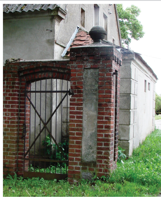
c) brama wjazdowa z zachowanymi ceglanyimi, ozdobnymi filarami (KEZ-A 810)
