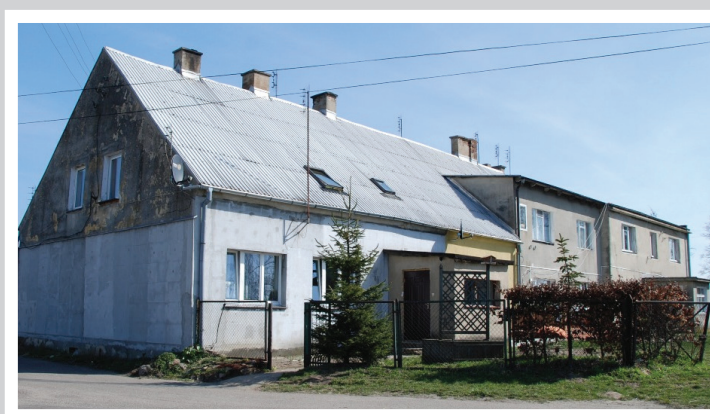
367. Majątek Wądół z dworkiem z przełomu XIX/XX w., to budynki w Lipianach ul. Sikorskiego 26, 28, 30 (KEZ-A 700-1)
