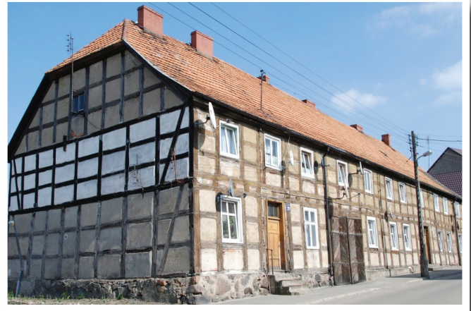
264. Budynek ul. Armii Krajowej 29, 31 ryglowy na cokole częściowo z kamienia łupanego z pocz. XIX w., wielorodzinny, o konstrukcji szkieletowej z dwoma sieniami i przejazdem bramnym z pocz. XIX w. (KEZ-A 512)
