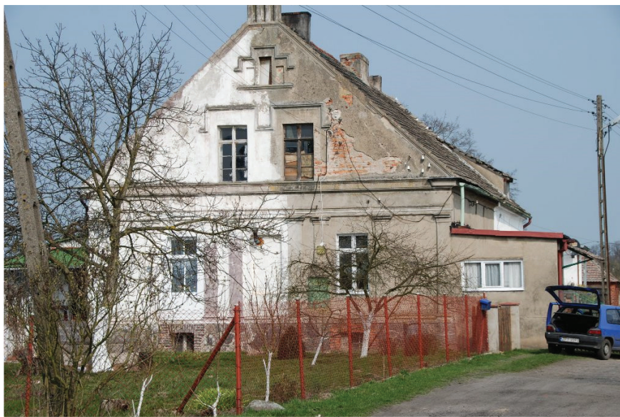
373. Żarnowo. Zagroda chłopska, zlokalizowana po północnej stronie drogi, w tym:
