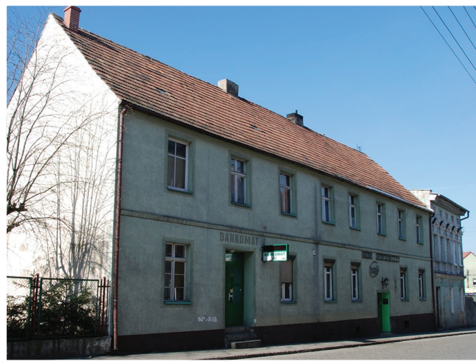
181. Budynek przy ul. Jedności Narodowej 50 z lat 20.30. XX w., siedziba władz miejskich od 1945 r., po 1950 Banku Spółdzielczego. Budynek murowany, być może z relikami konstrukcji ryglowej we wnętrzach, na rzucie wydłużonego prostokąta, podpiwniczony, (KEZ-A 580)
