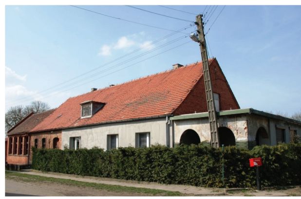
363. Budynek dawnej szkoły (obecnie kaplica), w centrum wsi, z cegły, nietynkowany, obiekt dwubryłowy złożony z dwóch dostawionych szczytami budynków (o zróżnicowanej wysokości), nakrytych dachami dwuspadowymi. (KEZ-A 818)
