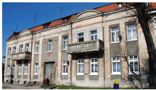
247. Jedności Narodowej 29. Budynek mieszkalny z pocz. XIX w. (KEZ -A 564)
