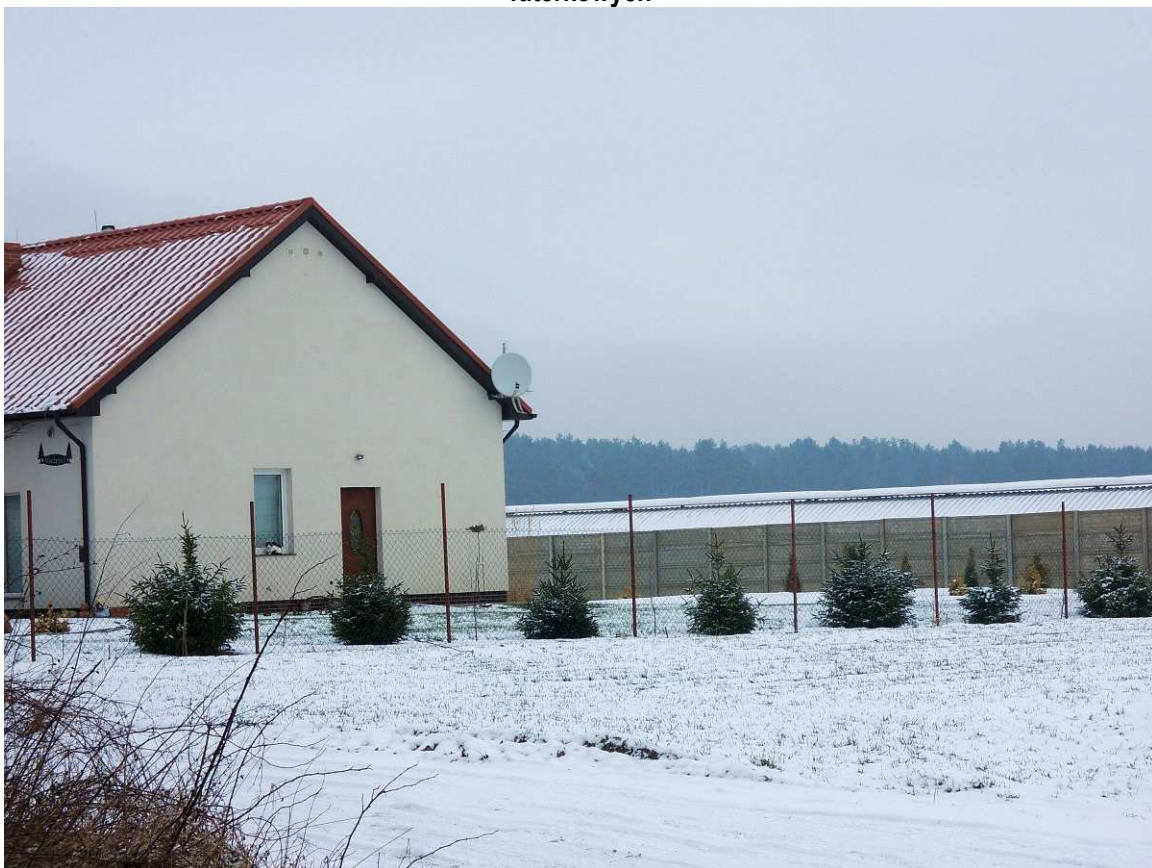
Fot. 5 Zachodnia część obszaru opracowania, budynek rolniczo – mieszkalny
