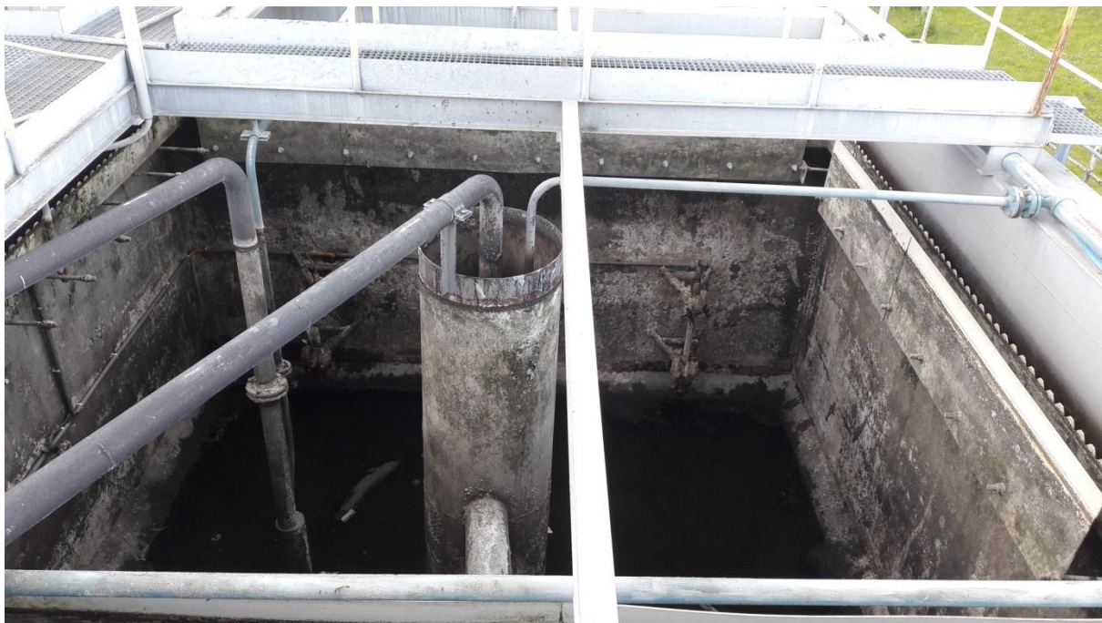
8. Ciąg technologiczny B800 - komora osadu czynnego
